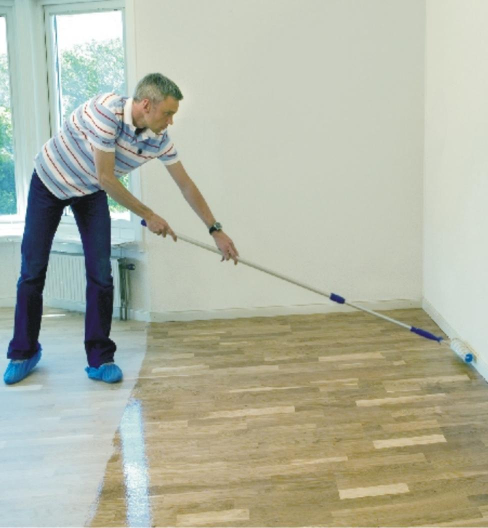
Tak můžete nepřetržitě sledovat lakovanou plochu a ihned opravit případná špatně nalakovaná místa. Nanášejte vrchní lak válečkem v pruzích cca 1,5 m po celé šířce místnosti (viz obrázek). Po dokončení dbejte na to, aby byl povrch chráněn před prachem. Po zaschnutí laku, po 2 – 3 hodinách, naneste po mezibroušení mezi jednotlivými vrstvami stejným způsobem druhou vrstvu laku (tak, jak uvedeno výše).
