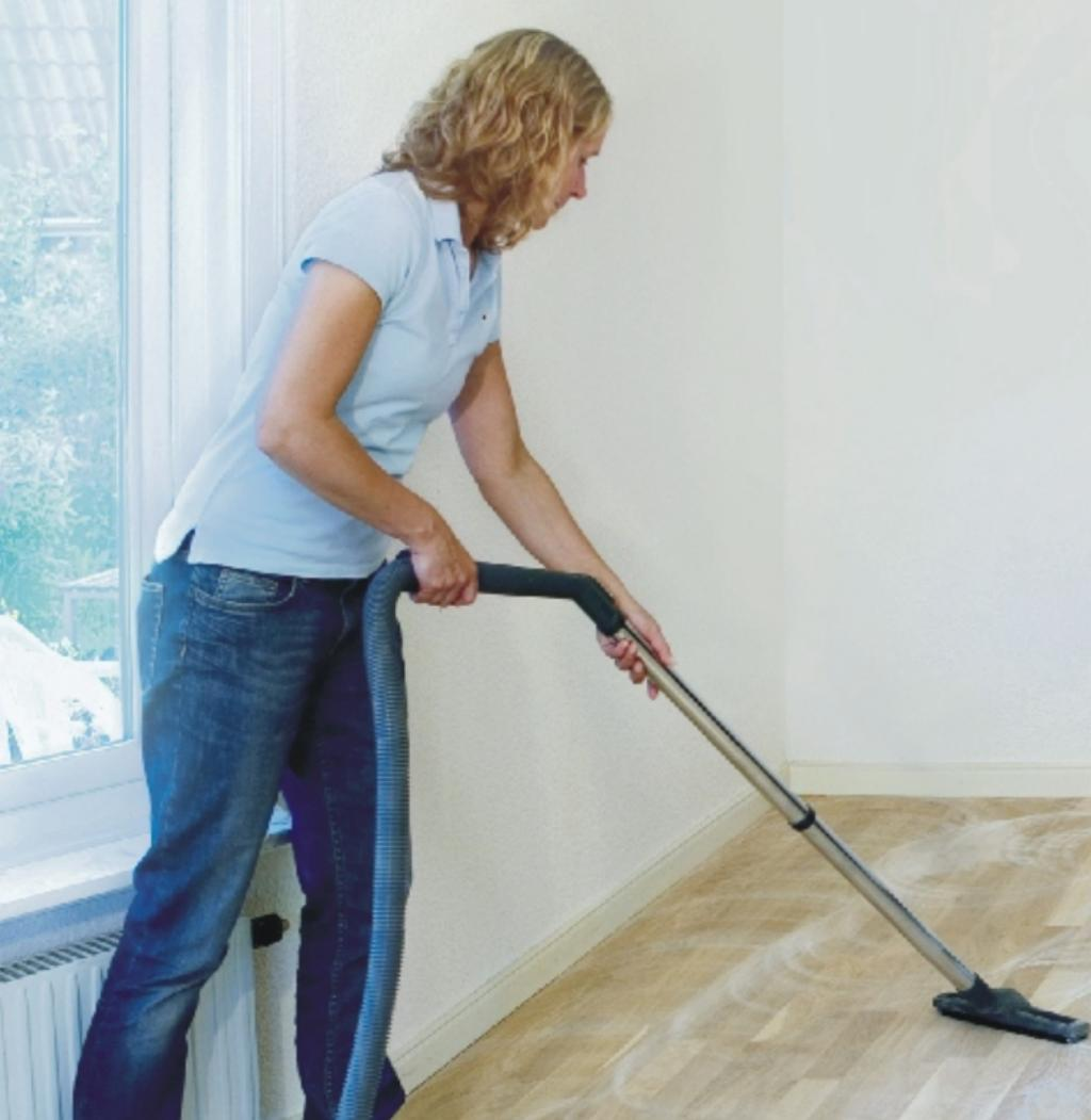
Předtím, než začnete nanášet poslední vrstvu vrchního laku, vysajte důkladně prach vzniklý broušením mezi jednotlivými nátěry.
