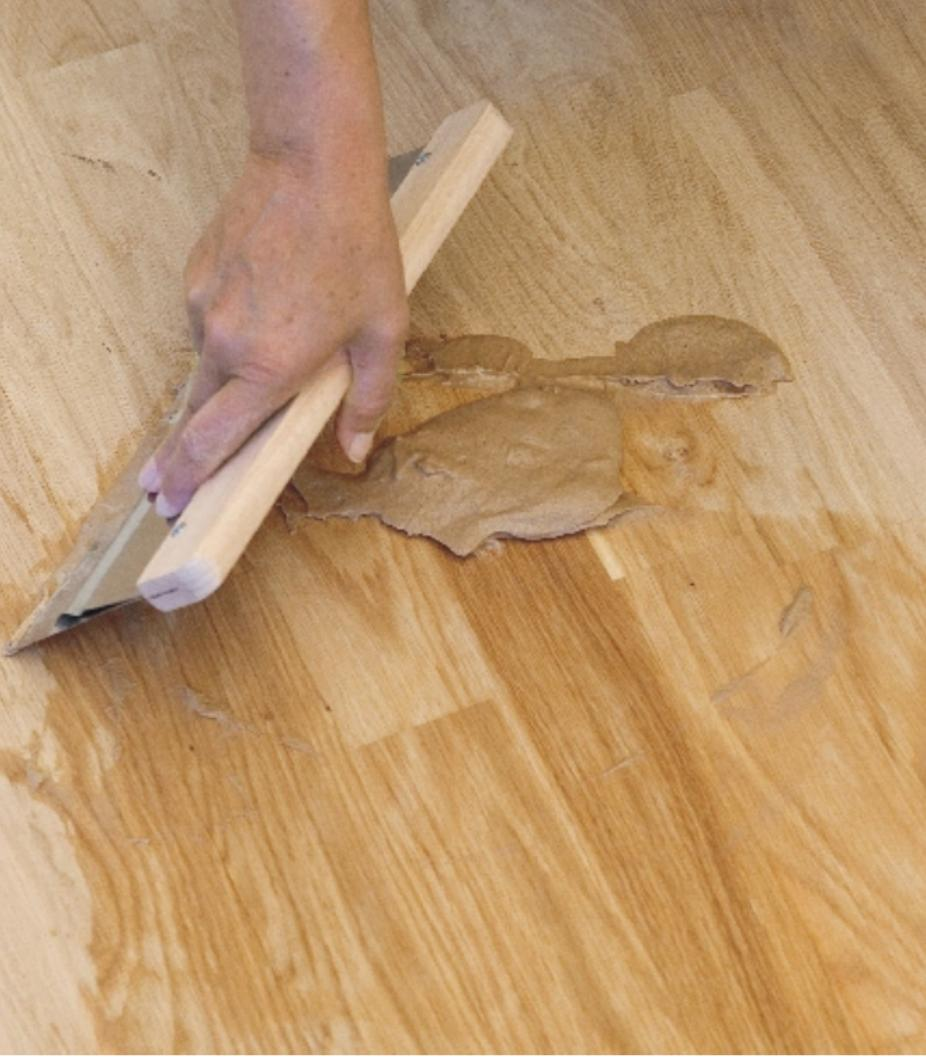
Pro vyplnění rýh naneste tmel plochou nerezovou stěrkou rovnoměrně po celé ploše do spár podlahy.
