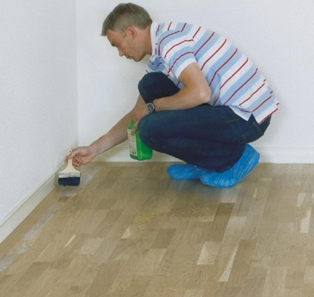
Dobré větrání zkracuje dobu schnutí laku – zabraňte však průvanu (dveřní spáry utěsněte lepicí páskou!).
